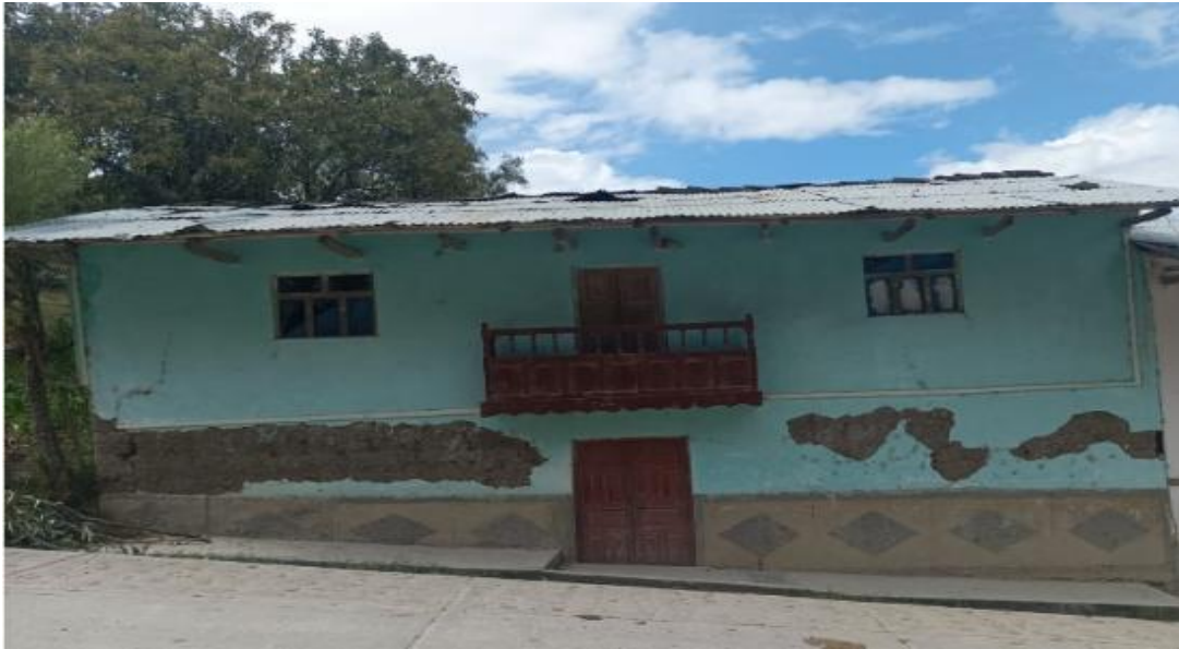
Figura 4. Edificación de adobe típica del lugar de estudio.
