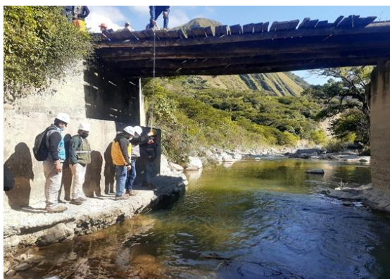
Figura 2. Visita y toma de datos básicos en el puente Chota
